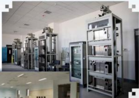
智能电梯安装调试 维护训练场所
